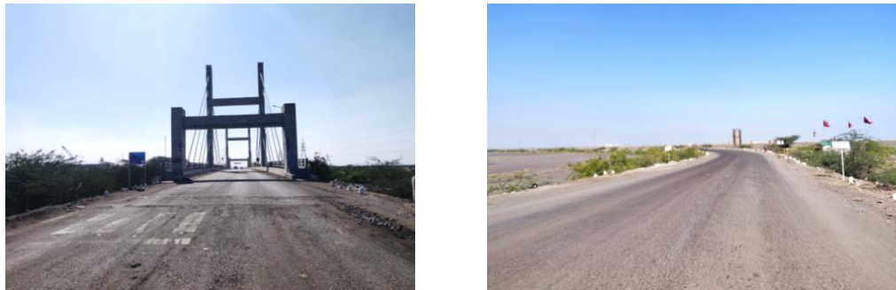
Project End Point (Kalatalav in Bhavnagar)
